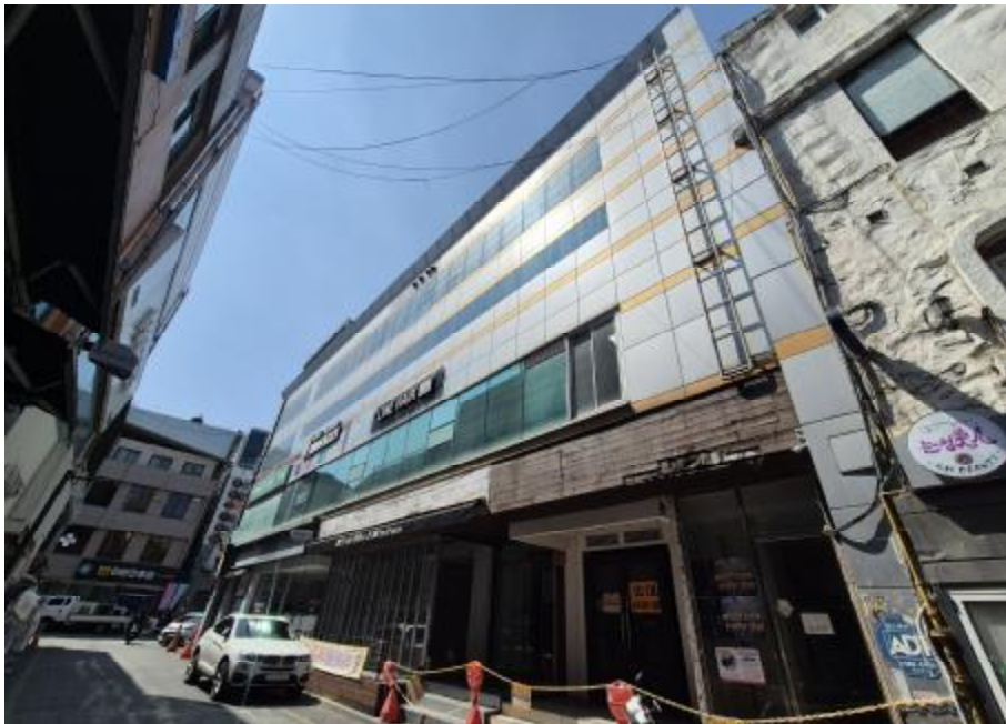
대상물건 전경 (동측)
