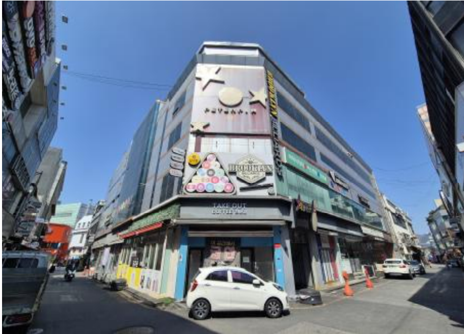
대상물건 전경 (남측)
