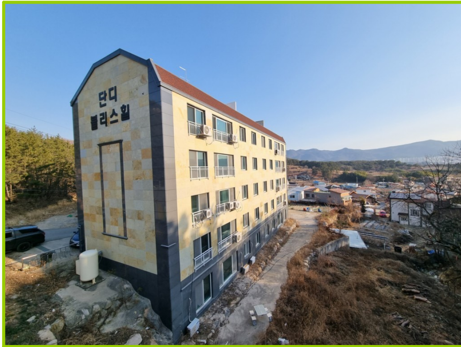
본건 전경(남서측에서 촬영)
